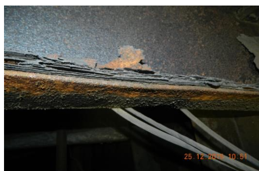
Рис.1 Металлоконструкция МНЛЗ подвержена коррозионному износу
