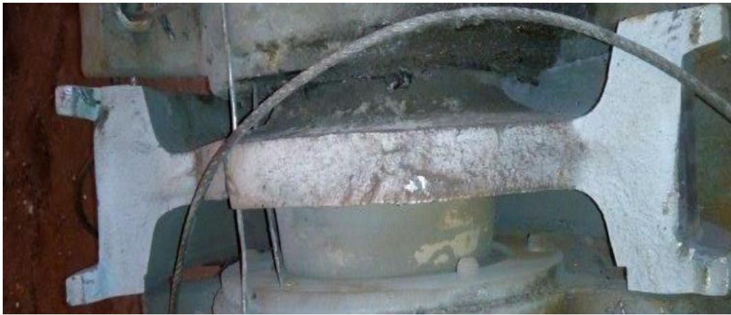
Рис. 1. Руйнування кранового колеса по маточині з виходом в зону катання
