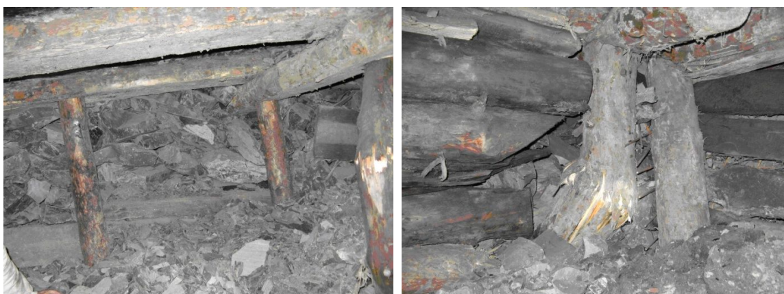
Рис. 6– Загальний вигляд бутової смуги (а) та деформування елементів дерев'яного кріплення внаслідок її розповзання (б)
