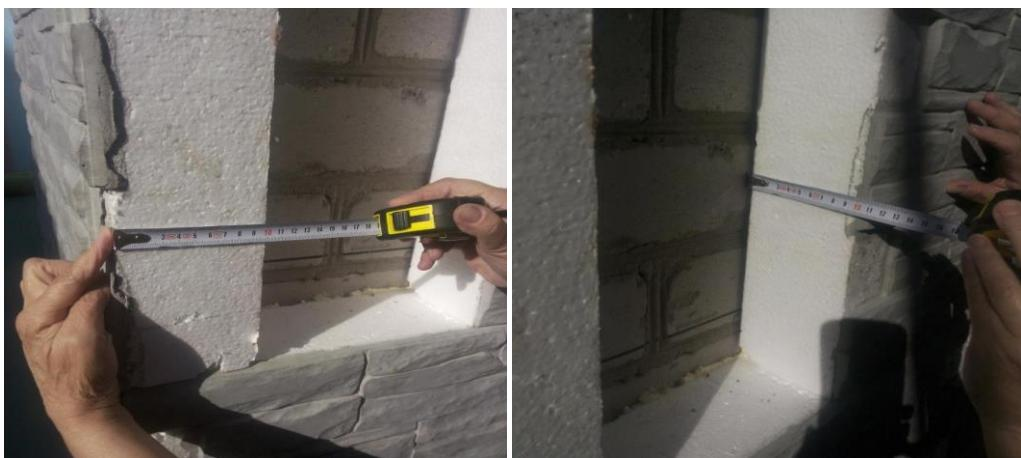
**Рис. 5. Товщина утеплювача, зафікована при монтажі**
