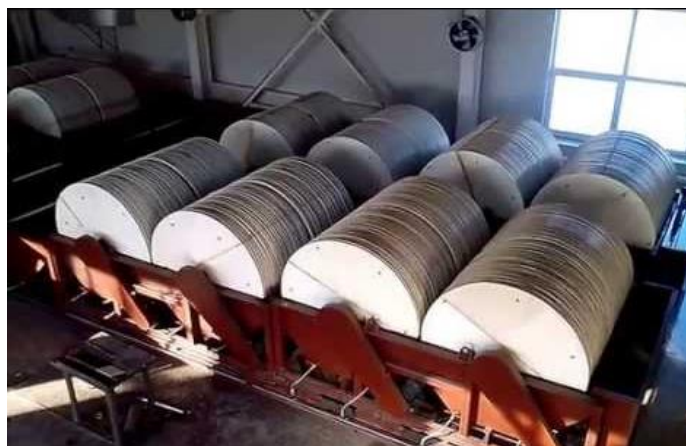
Рис. 10. Биофильтр с дисковой загрузкой
