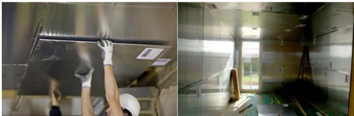
Рис. 2. Елементи DuPont™ Energain із гіпсокартону з фазоперехідним матеріалом
