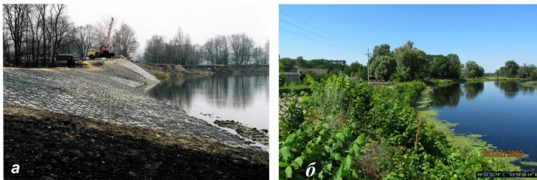
Рис. 1. Кріплення берега річки
