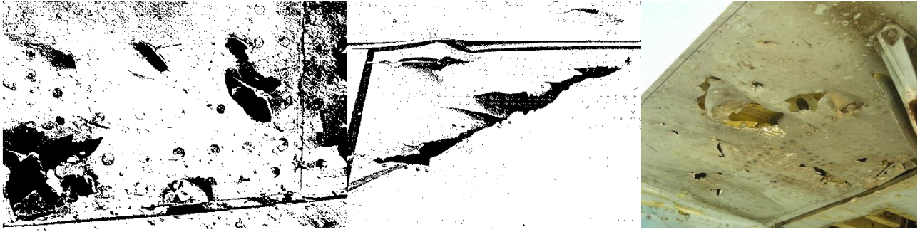
Рис. 4. Бойові пошкодження конструкції літального апарату
