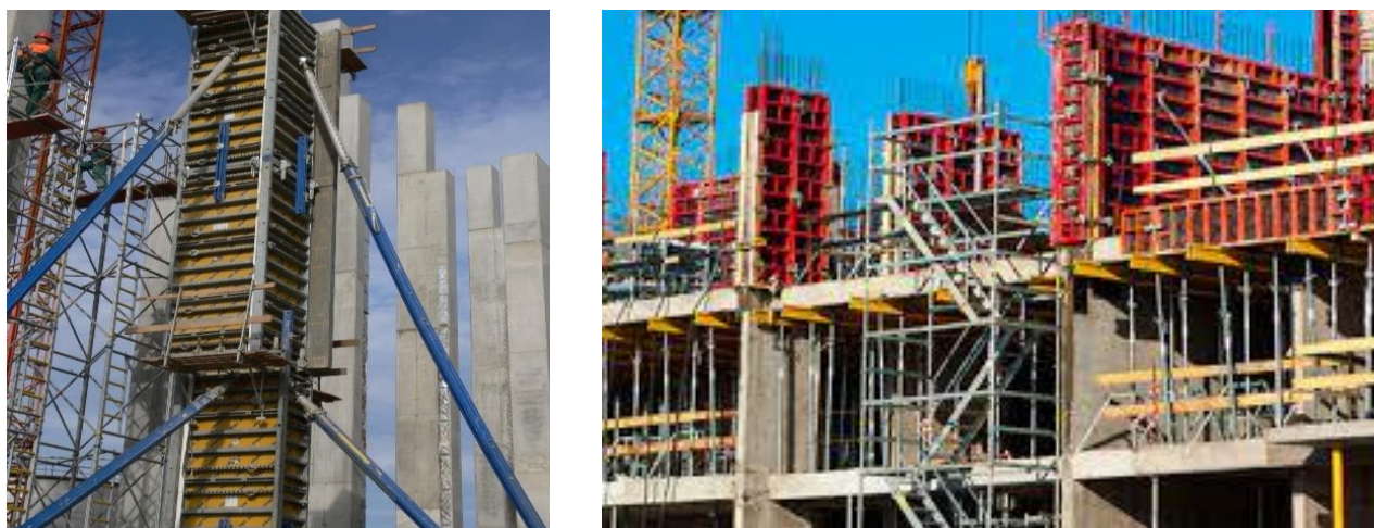
Рис. 2. Опалубка для колон фірм DOKA і PERI
