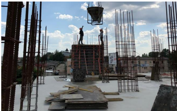
Рис. 1. Зведення будинку за каркасно-монолітною технологією
