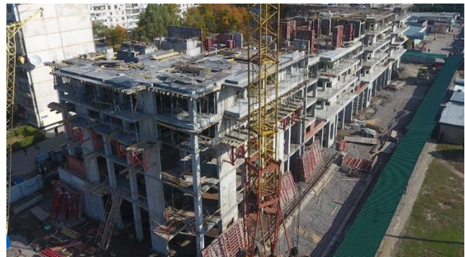
Рис. 1. Зведення будинку за каркасно-монолітною технологією
