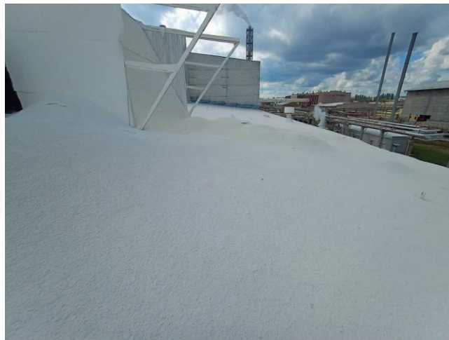
Фото 3. Накопичення технологічного пилу насиченого вологою на поверхні покрівлі
