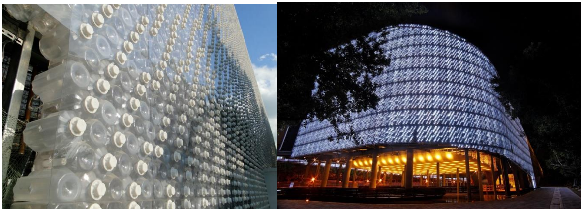
Рис. 1. Блоки з перероблених пластикових пляшок у проєкті EcoARK Pavilion, Тайбей, Тайвань
