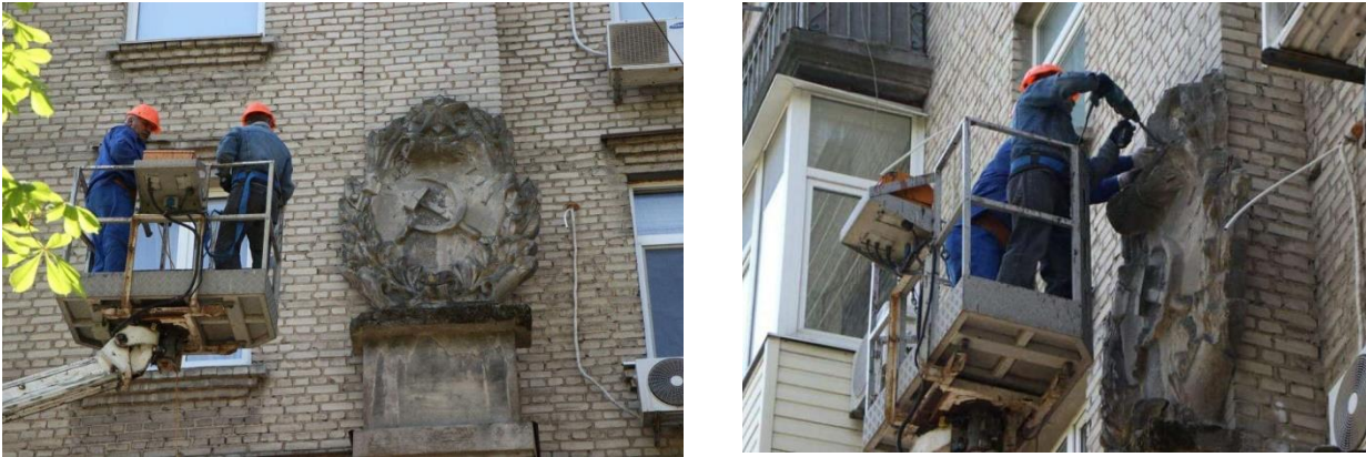
Рис. 3. Демонтаж бетонної ліпнини - декоративного елементу з радянською символікою.
