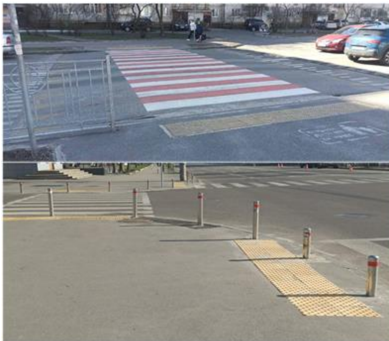
Рисунок 3. Обладнані пішохідні переходи належним чином.
