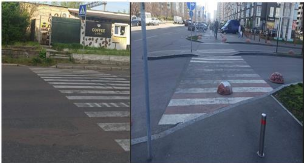
Рисунок 2. Облаштування пішохідного переходу без урахування потреб осіб з інвалідністю
