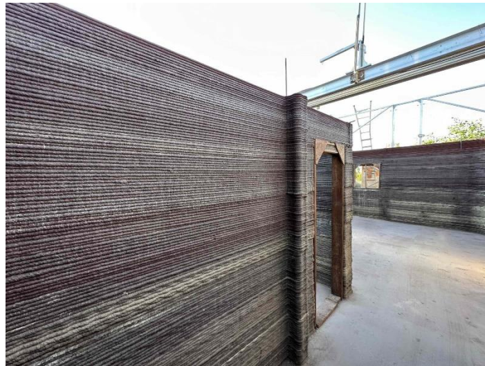
Рис. 2. Геополімерна 3D-друкована стінка (місто Масса-Ломбарда, Італія) [1]
