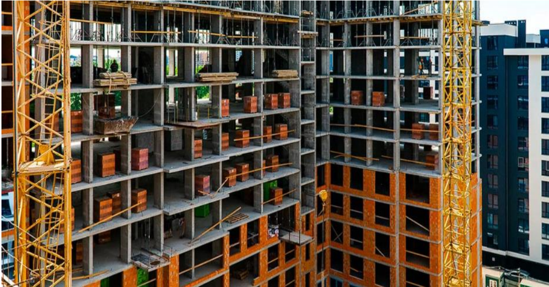
Рис. 3. Процес будівництва монолітно-каркасної будівлі
