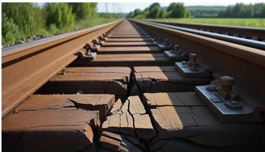
Рис. 1. Руйнування дерев'яних шпал в умовах експлуатації колії
